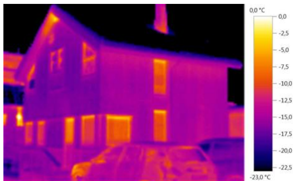
Рис. 1. Термограмма деревянного модульного здания
