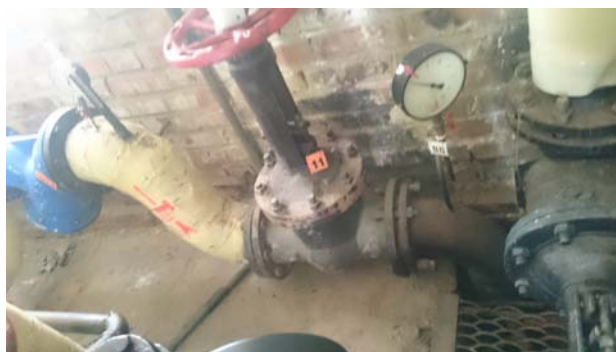
Рис. 3. Фланцевая стальная задвижка типа 30с15нж диаметром 150 мм (11), установленная вблизи манометра (96) на обратной линии отопления из квартала
