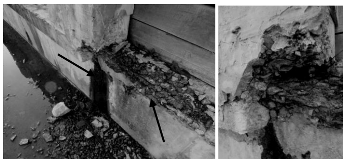
Рис. 1. Разрушение защитного бетонного слоя, оголение и коррозия арматуры железобетонной стенки нагильного пруда, вследствие совместного действия биологической и химической коррозии
